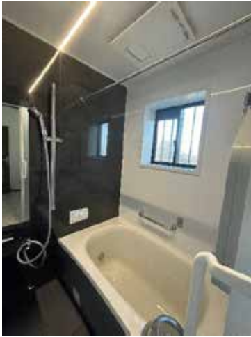
安八郡 N 様邸 浴室取替
