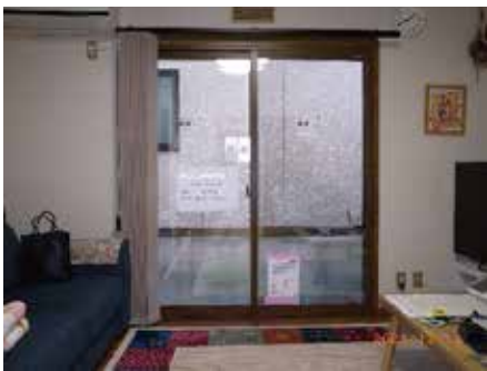
岐阜市 H 様邸 内窓取付
