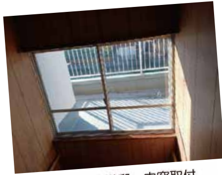
大垣市 M 様邸 内窓取付
