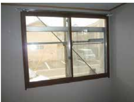
本巣郡 T 様邸 内窓取付
